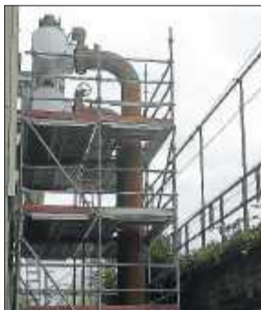
Es wurden auch schon Fernwärmelösungen verlegt.
