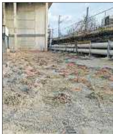
Das Baufeld ist fertig. Es liegt direkt an den Bahngleisen.
